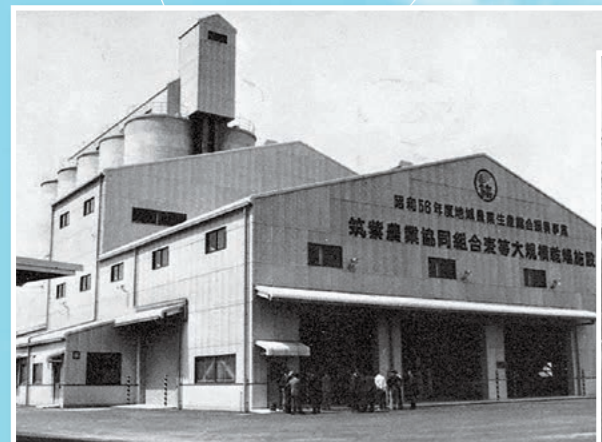
▲カントリーエレベーター完成
