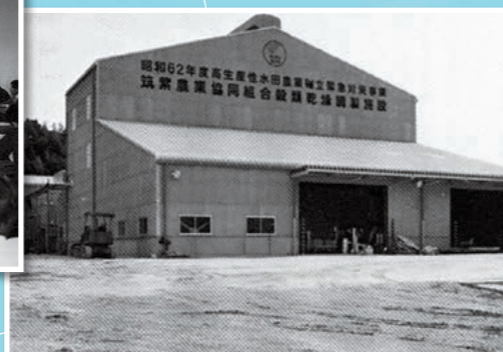
▲那珂川ライスセンター完成
